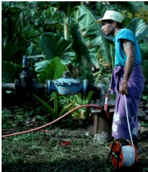
Samoa Occidental: La sobreexplotación de las aguas subterráneas puede traducirse en la salinización de los abastecimientos de agua
